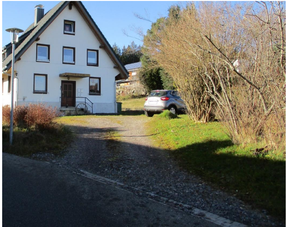
Geschotterte Zufahrt und Stellplätze des Hauses Nr. 14
