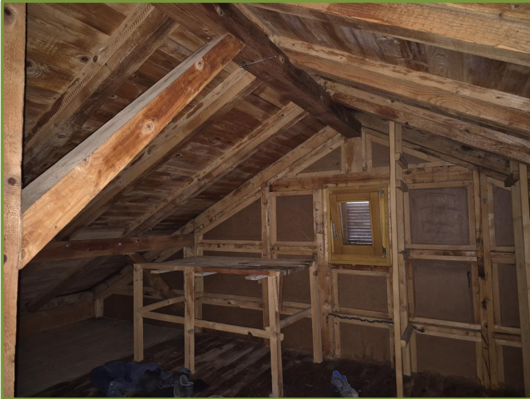
Abb. 7: Ansicht des Dachstuhls des Gebäudes.
