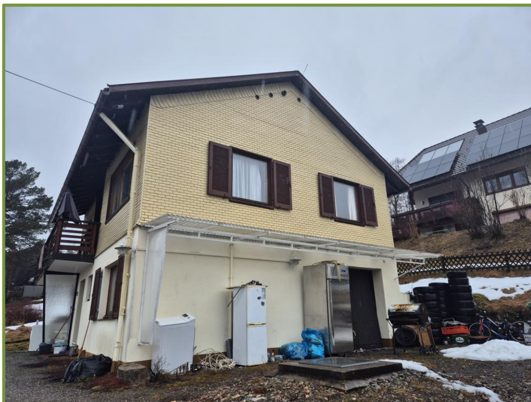
Abb. 2: Außenansicht des Gebäudebestands.
