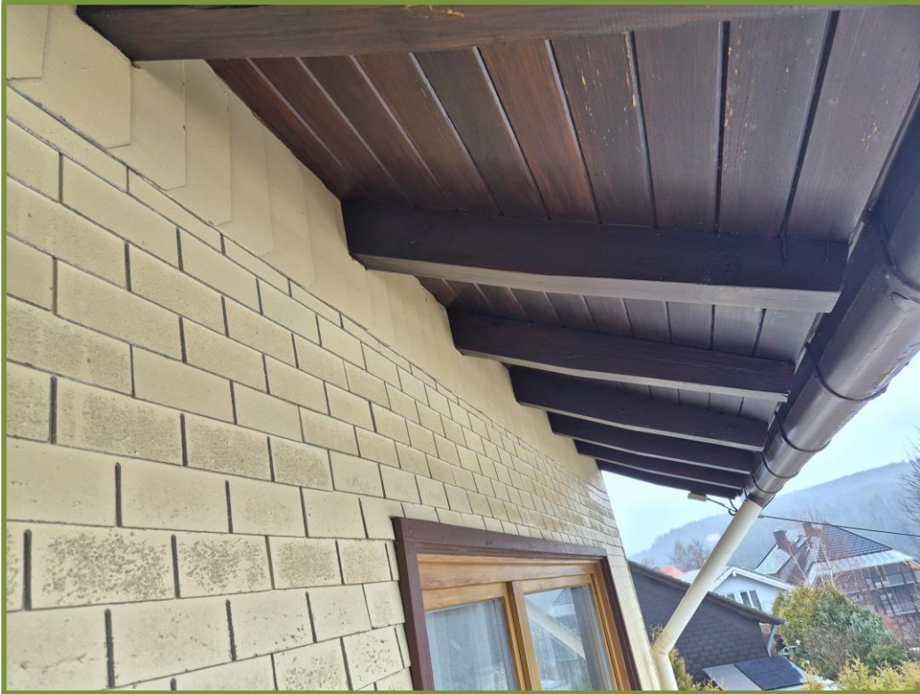
Abb. 3: Dachtraufe und Außenverschalung mit potenziellen Spaltenquartieren für Fledermäuse.
