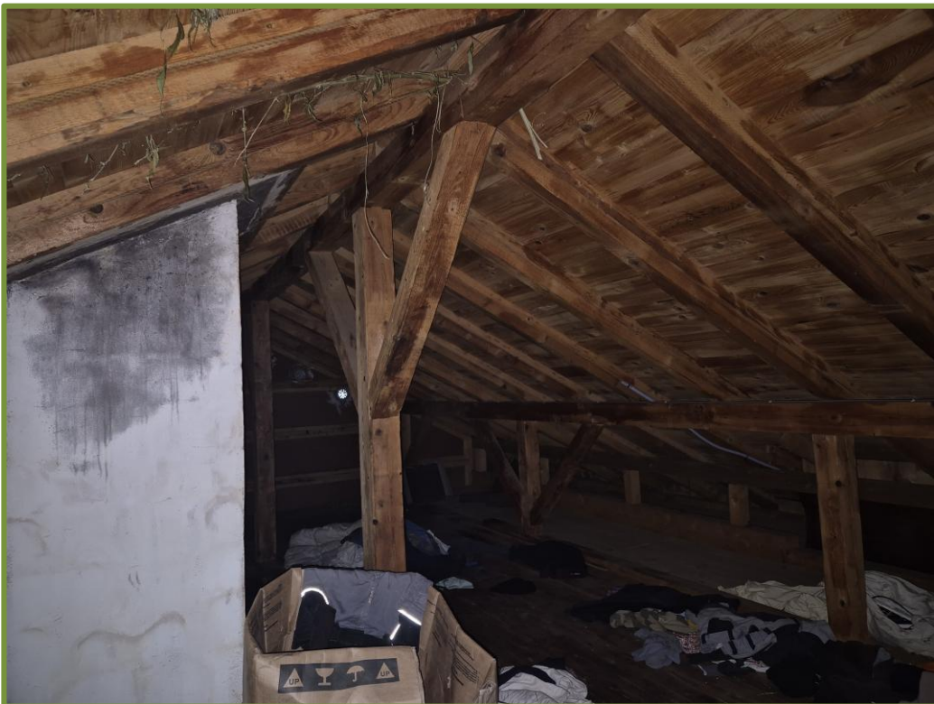
Abb. 6: Ansicht des Dachstuhls des Gebäudes.
