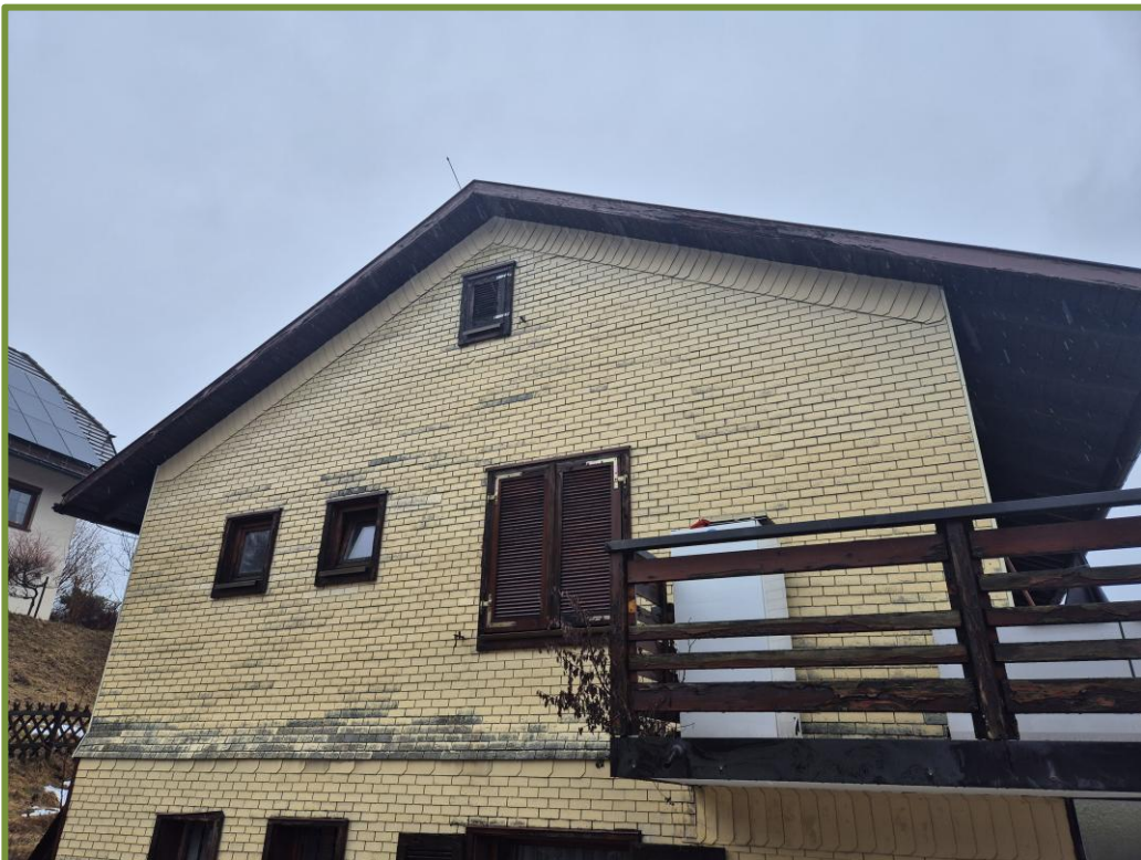
Abb. 4: Giebelseite der Außenfassade mit Quartierpotenzial für Fledermäuse.
